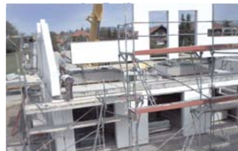
Stellen einer Wand im DG
