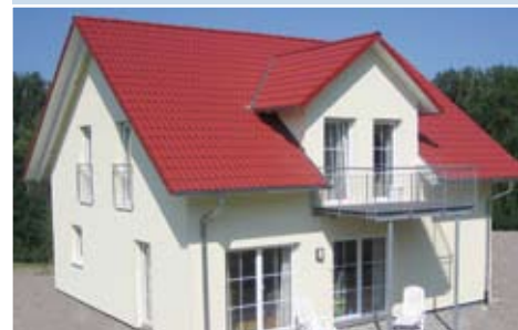
Dacheindeckung mit HEIDELBERGER Verona
