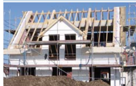
Dachstuhl-Holzkonstruktion
