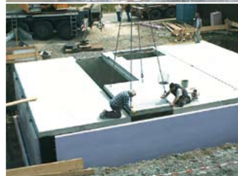
Erstellung der Decke im Untergeschoss
