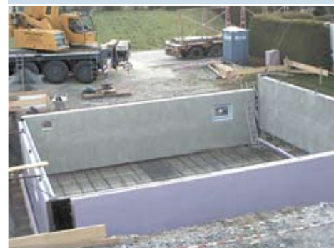
Erstellung der Wände im Untergeschoss
